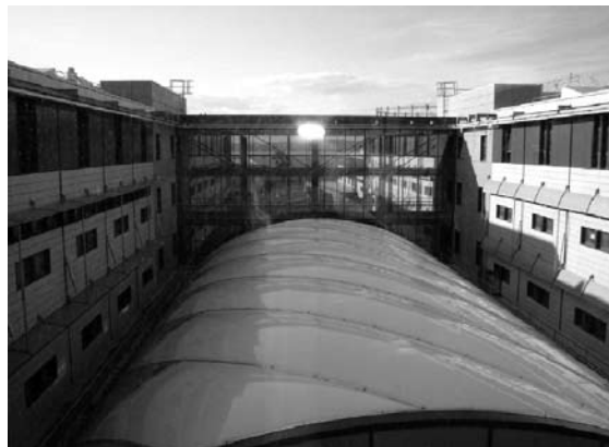
FIGURA 15: Vista aérea da cobertura de ETFE
